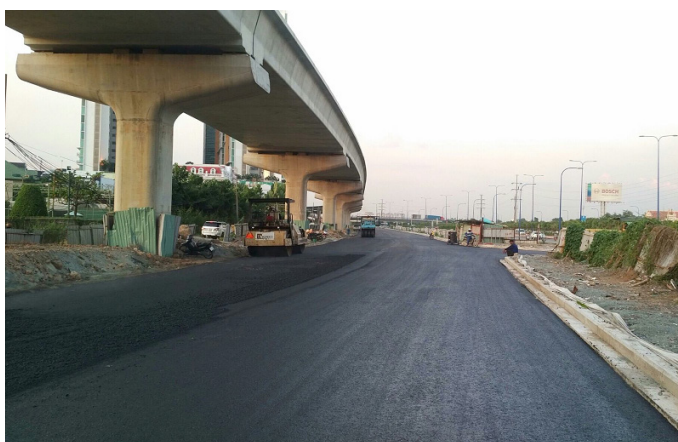
Thi công thảm bê tông nhựa (Đoạn từ đường Võ Trường Toản đến đường Giang Văn Minh)
