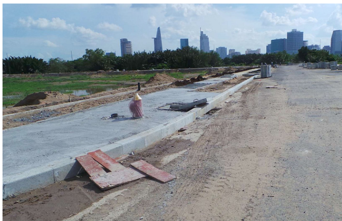
Thi công vỉa hè đường R10
